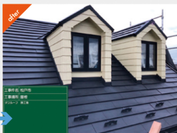
屋根カバー工法 施工事例
